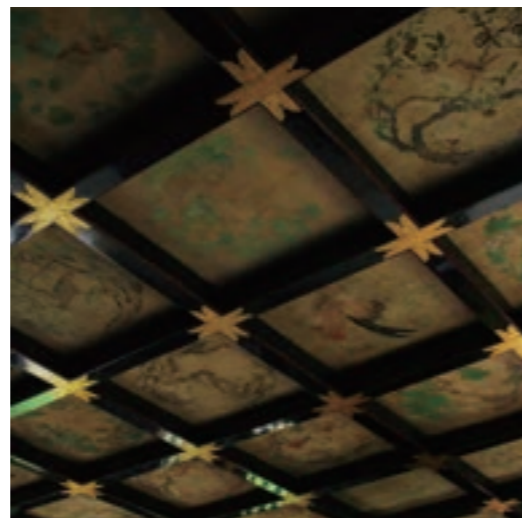
格天井とは太い角材を井桁状に組んだ天井で、格式の高い建物に用いられる。
