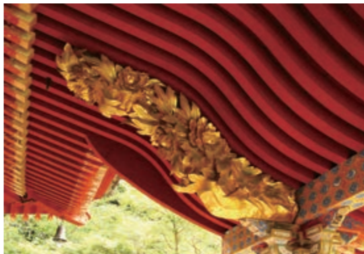
手扶（たばさみ：向拝柱の内側に、屋根の垂木勾配に沿って入れられた化粧板）には、金色の八重牡丹と葉が立体的に浮き彫りされている。
