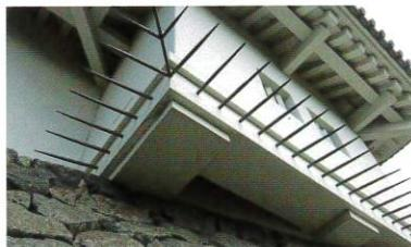
石落し■ 天守台の張り出し部に設けられ、石垣を落としたり、櫓を突き出したりして、石垣を登ってくる敵を攻撃する施設。
