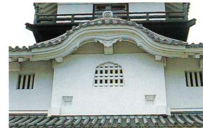
軒唐破風と火燈窓■ 破風とは、軒の三角形部分をさし、掛川城天守閣に用いられているものとされる壁面に取り付けた、床脚風と呼ぶ
