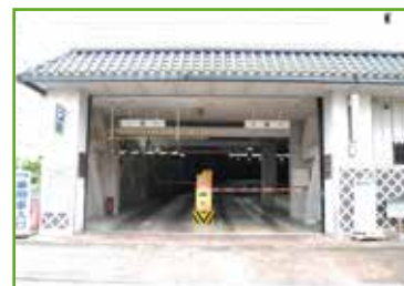
大手門駐車場入口
